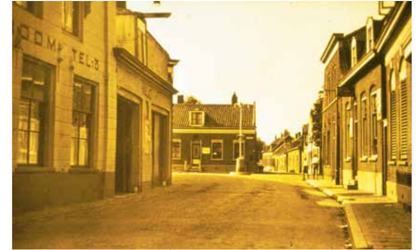
Het pakhuis aan de Dorpstraat in Bergschenhoek is het laatste pand links, met de grote open poort, en zou tot 1962 dienstdoen.
